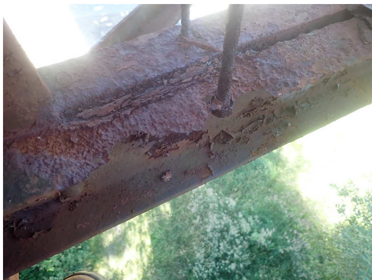
Foto č. 3 Konstrukce K 02 – 8. dolní příčné ztužení hlavních nosníků vpravo – korozní oslabení až do ostra
