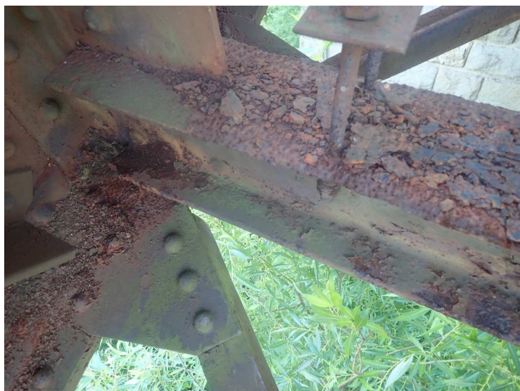
Foto č. 7 Konstrukce K 03 11. dolní příčné ztužení hlavních nosníků vpravo – korozní oslabení až do ostra
