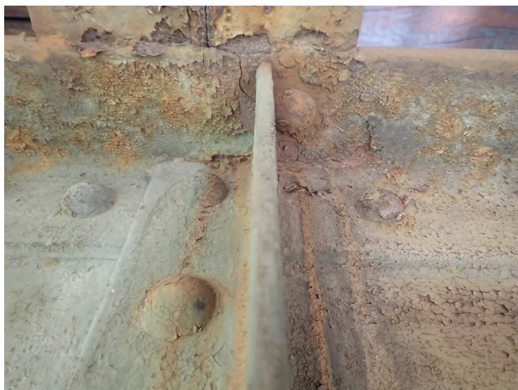
Foto č. 4 Konstrukce K 03 – 2. příčník vlevo – horní pásnice pod podélníkem – trhlina – foto z 1. pole
