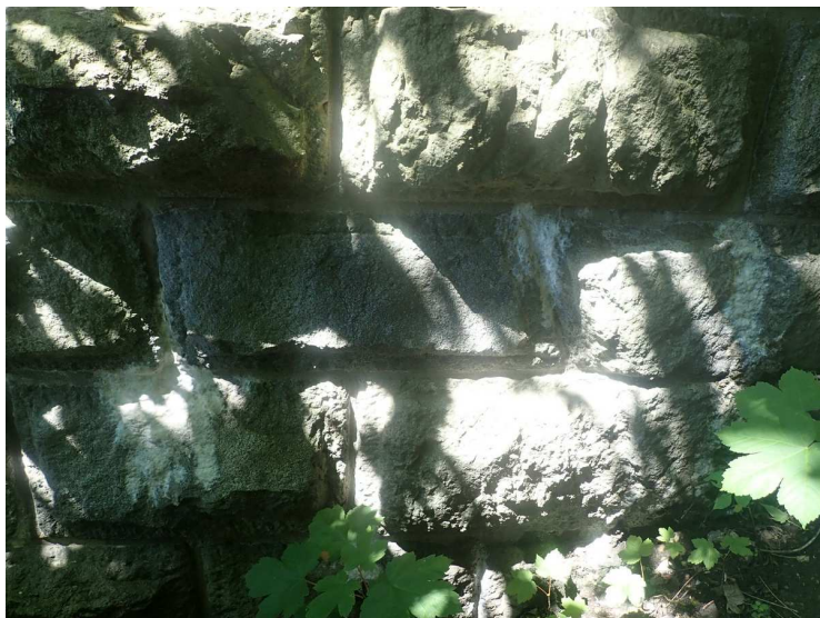
Foto č. 10 Opěra O 01 –křídlo vlevo průsak vody a pojiva
