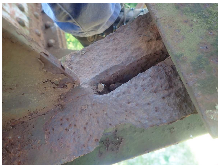
Foto č. 2 Konstrukce K 02 – 6. dolní příčné ztužení hlavních nosníků vpravo – korozní oslabení až do ostra
