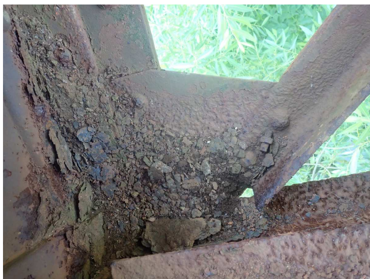
Foto č. 6 Konstrukce K 03 – 11. dolní příčné ztužení hlavních nosníků vlevo – styčnickový plech z 12. pole – korozní oslabení
