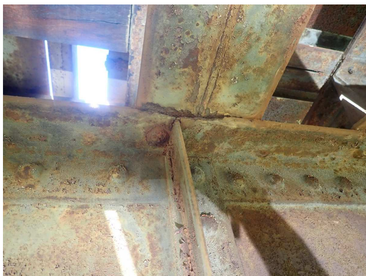
Foto č. 5 Konstrukce K 03 – 2. příčník vlevo – horní pásnice pod podélníkem – trhlina – foto z 2. pole
